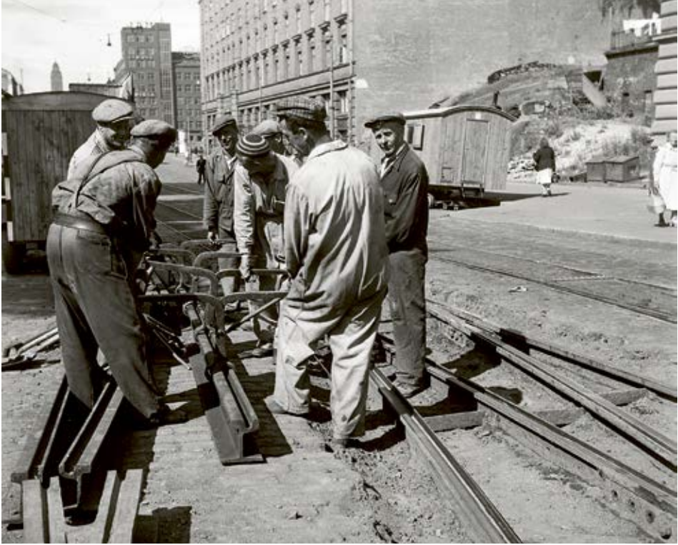
Sodan jälkeen suomalaiset uurastivat myös liikenneinfrastruktuurin hyväksi. Raitiovaunukiskojen vaihtoa Helsingin Kaisaniemessä 1948.
