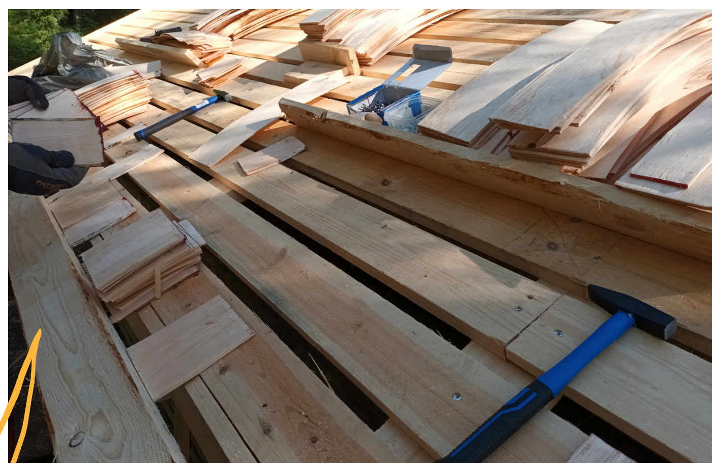
Ensimmäisiin kahteen riviin räystäällä tulee lyhyempiä päreit kupera puoli ylöspäin
