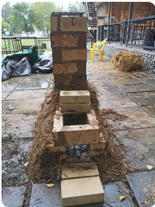
Kuva 2 Rakettiliesi rakenteilla tulitiilistä savi-olki-eristyksellä
