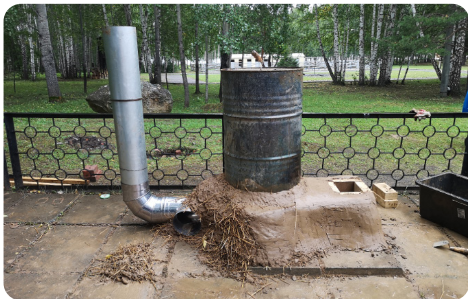
Esimerkki rakenteilla olevasta kesäkeittiöstä. Hormin ympärille lisätään vielä massaa.
