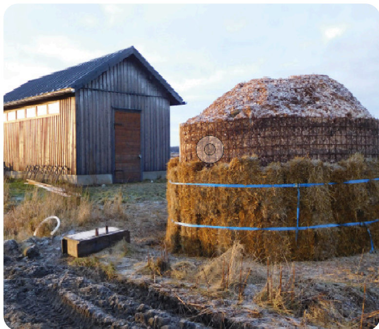
Kuva 5: Olkipaalleristys biomeilerin ympärillä
