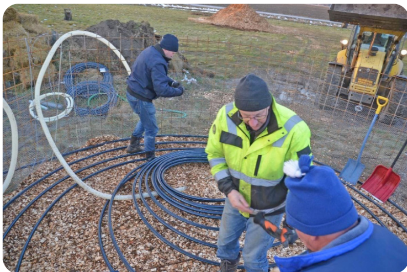
Kuva 3: Kyläläiset avustivat biomeilerin rakentamisessa, ensimmäisen putkikerroksen asentaminen menossa.
