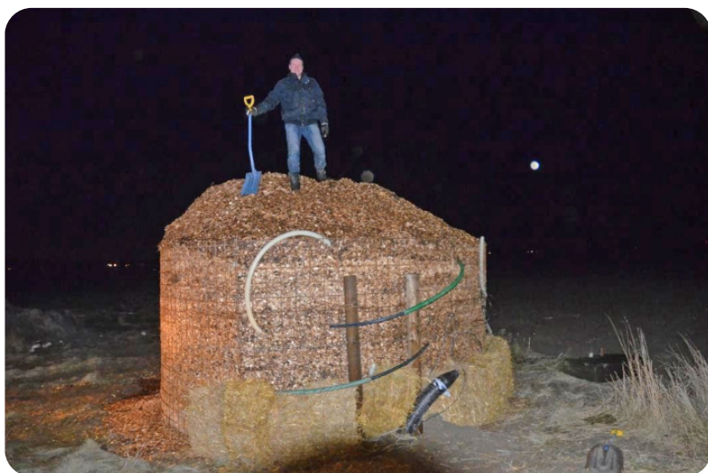
Kuva 4: Täyttö valmis, 50 m 3 täynnä ja eristyksen laitto aluillaan.
